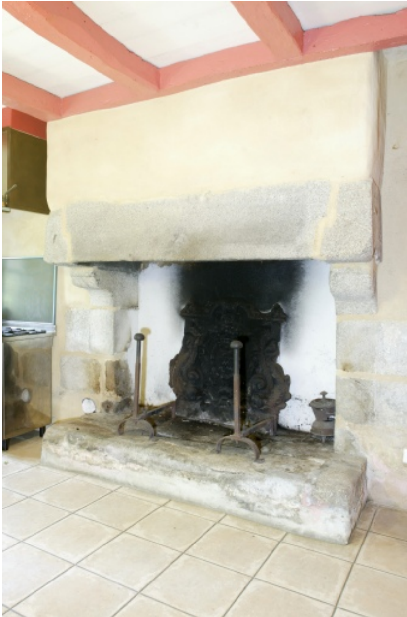
Cheminée au rez-de-chaussée de la partie sur jardin.
