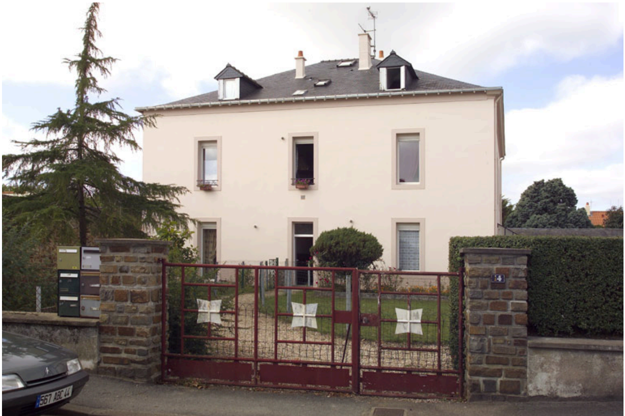
Vue d'ensemble de la façade est.
