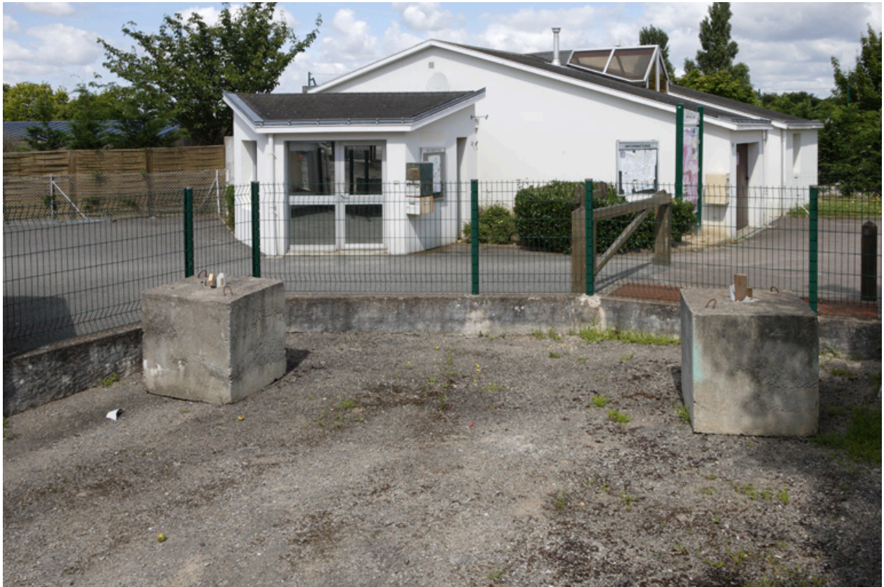
Ecole René-Guy Cadou, rue du Bois-Lagland, vestiges de l'installation.
