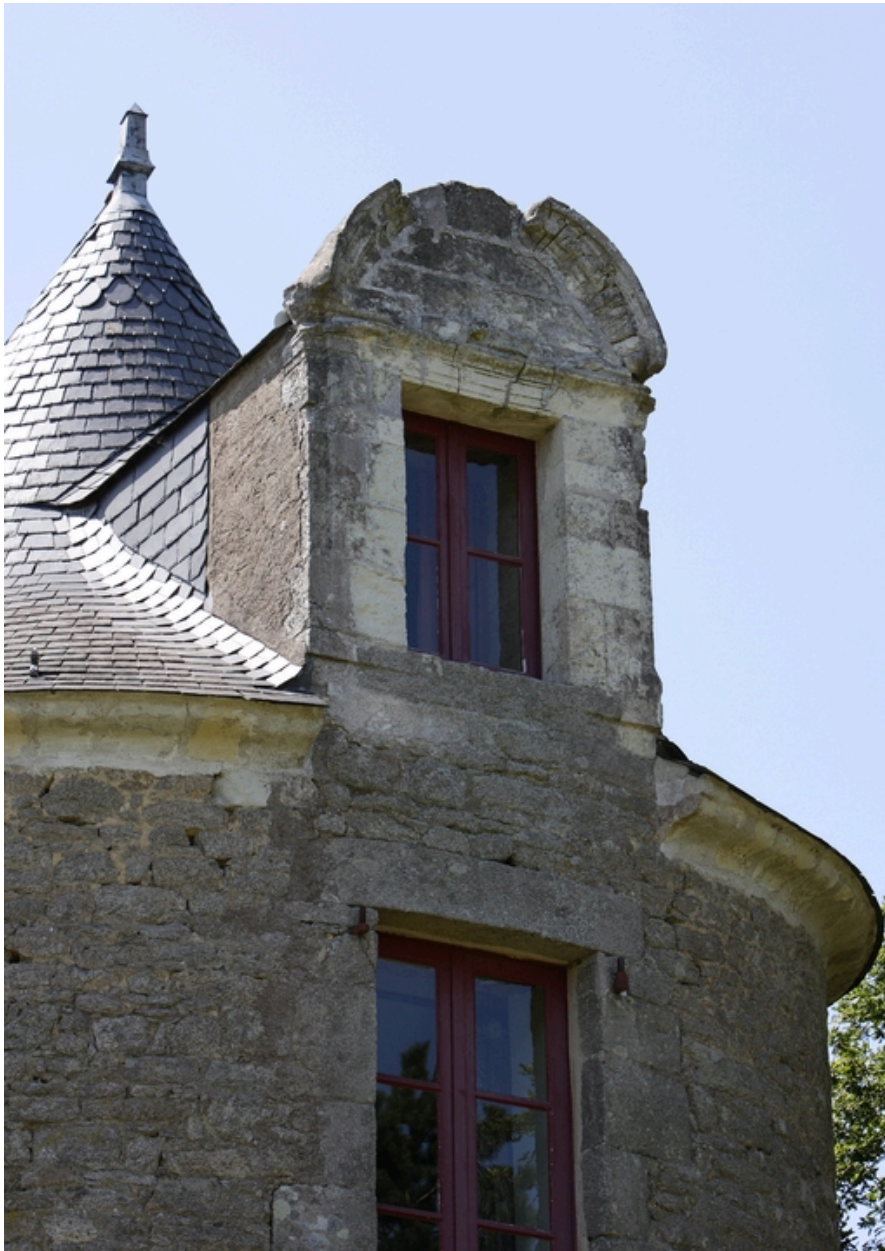
Façade est. Détail de la lucarne de la tour.
