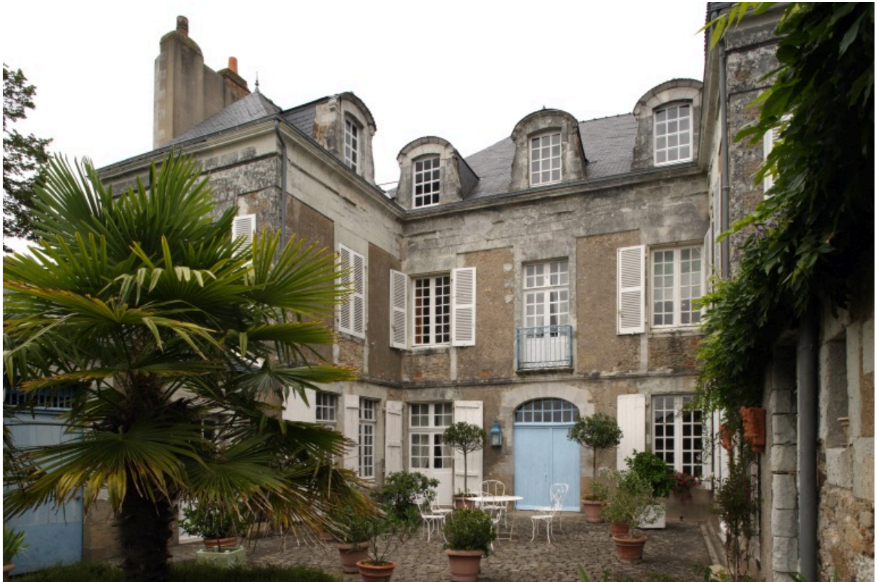
Vue des façades postérieures depuis le jardin.
