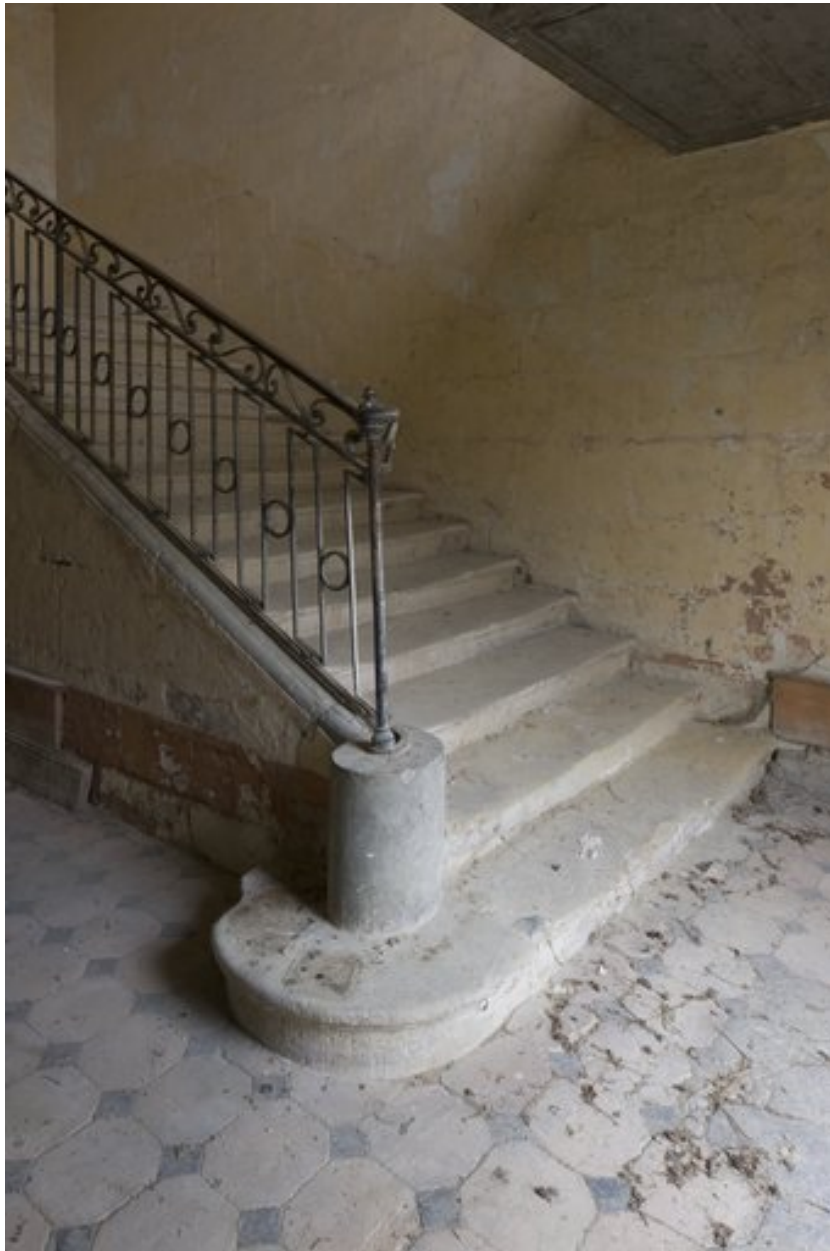
Escalier tournant établi vers 1800, détail.
