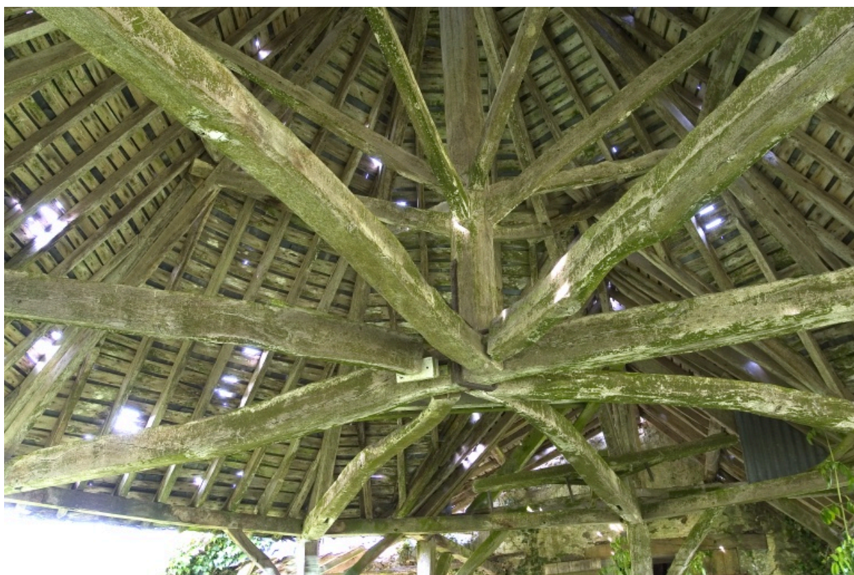
La remise : charpente de l'abri du manège à chevaux.
