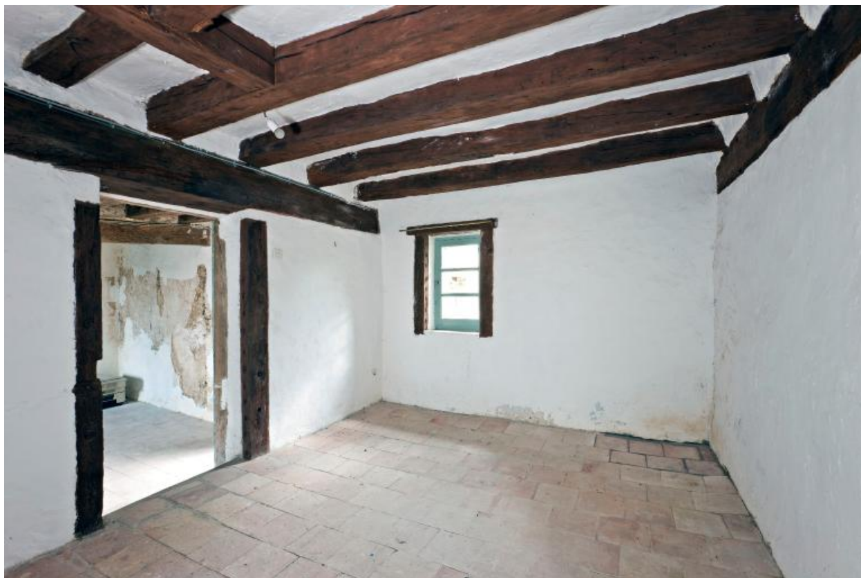
Maison 1 : pièce froide.
