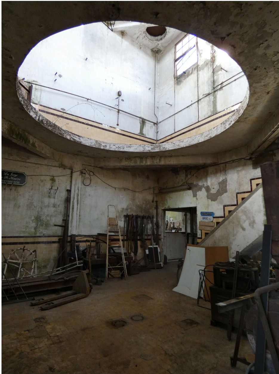
Le rez-de-chaussée du bâtiment d'atomisation, avec emplacement de la tour métallique.
