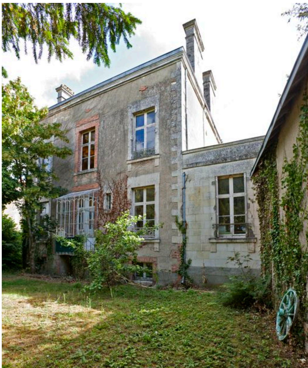
Vue de volume de la façade sur le jardin : aile basse en terrasse.
