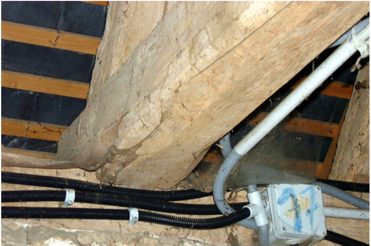
Charpente dans la partie orientale du logis. Détail de l'extrémité de l'entrait avec un congé.
