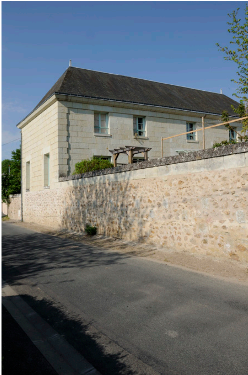
Vue depuis la rue : ancienne grange (devenue maison).
