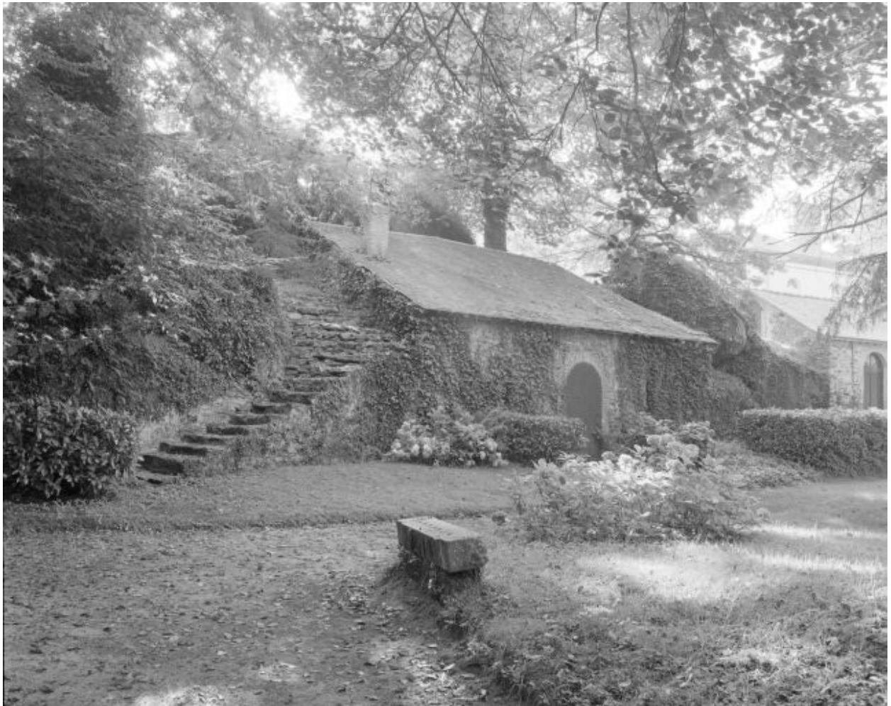
Ancien magasin. Façade sud.
