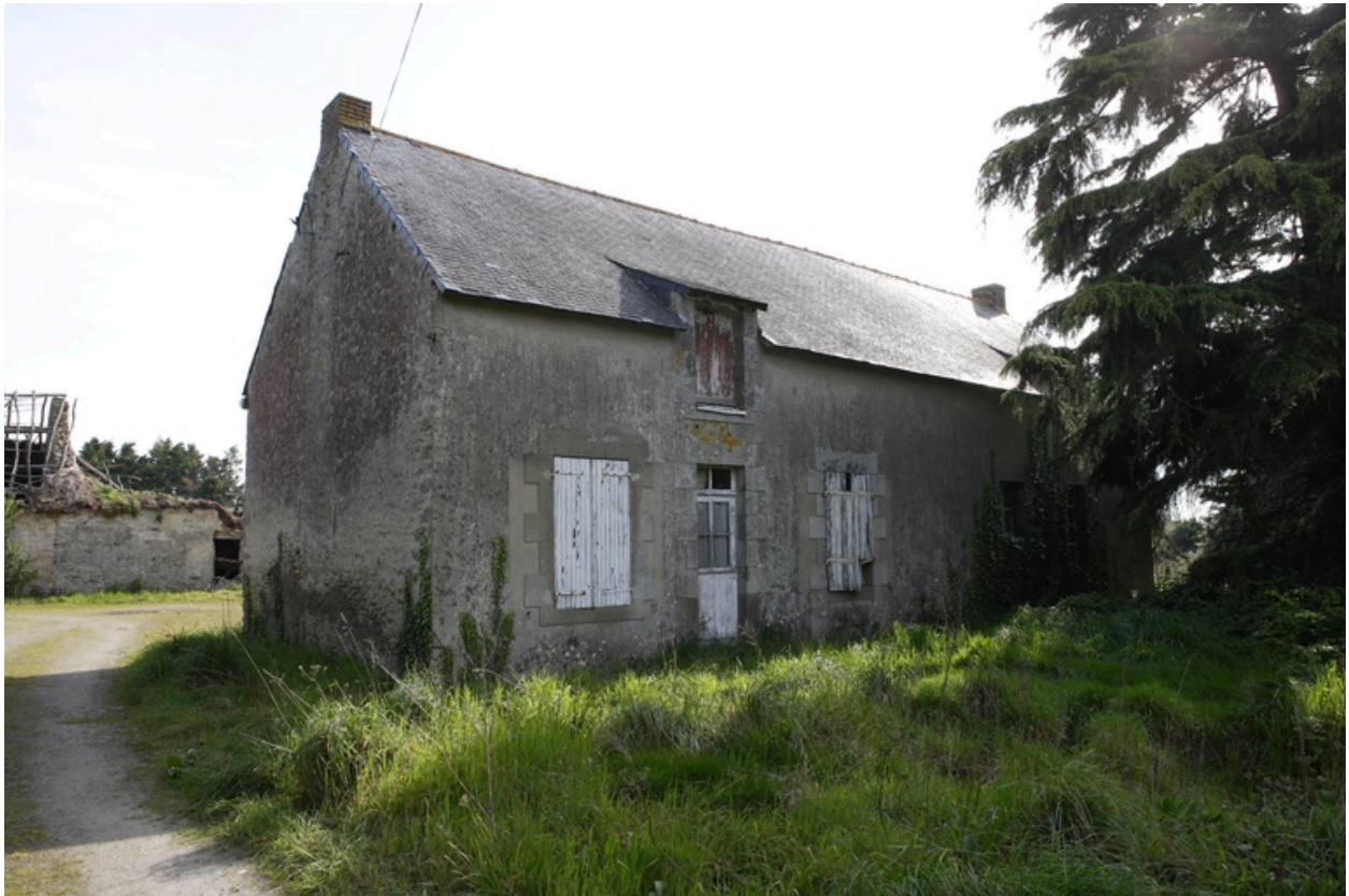
Vue de la façade sud du logis neuf.
