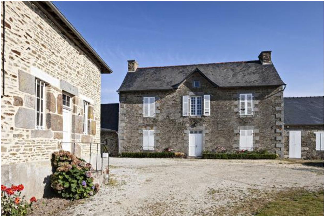
Presbytère de Thubœuf et accès à la sacristie depuis la cour.
