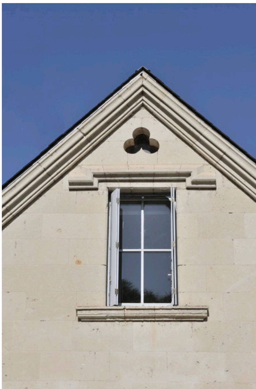
Communs (façade sud) : détail de la baie néogothique de l'étage.
