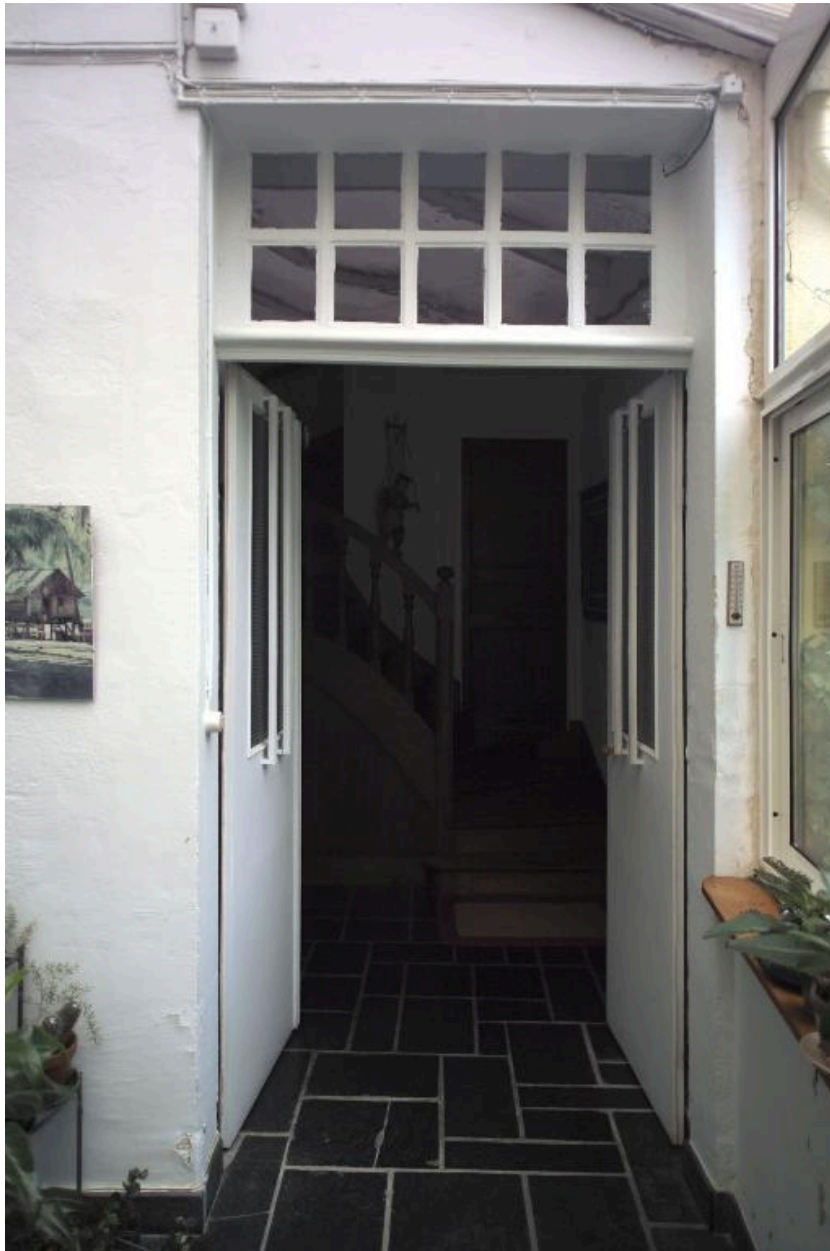
La porte d'accès à l'escalier.
