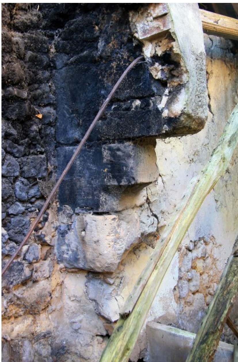
Cheminée de la petite maison : profil du piédroit et de la hotte en pierre.
