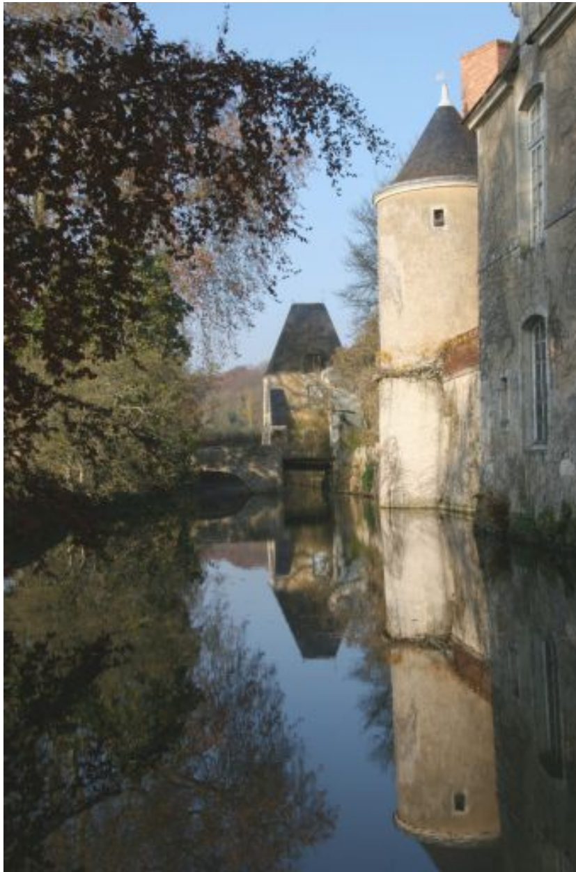
Rive ouest des douves.
