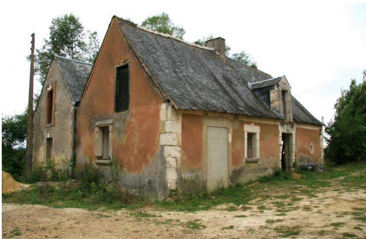
Parcelle 466 : la maison d'habitation et les étables sous un même toit.
