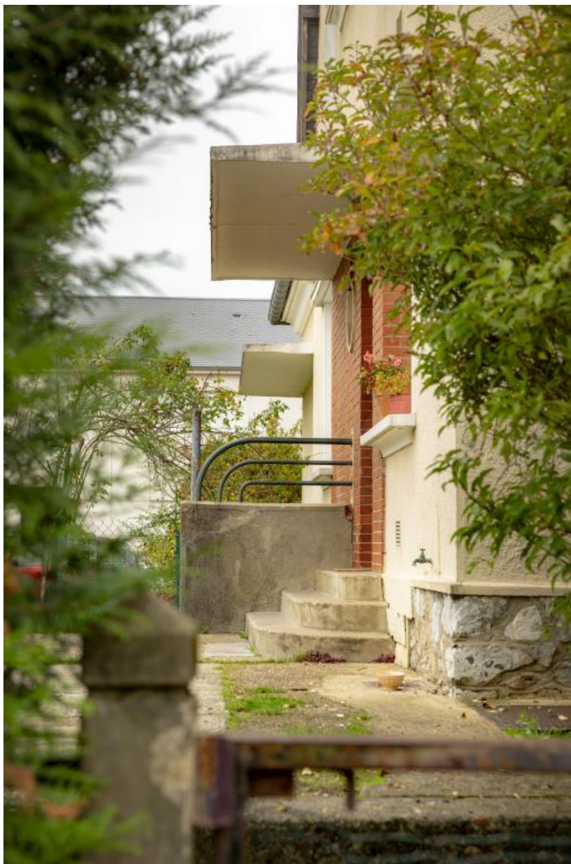
Vue de l'entrée de pavillon de type 1.
