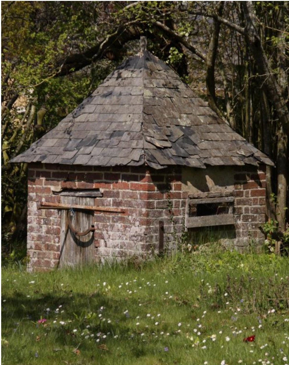
Puits en brique.
