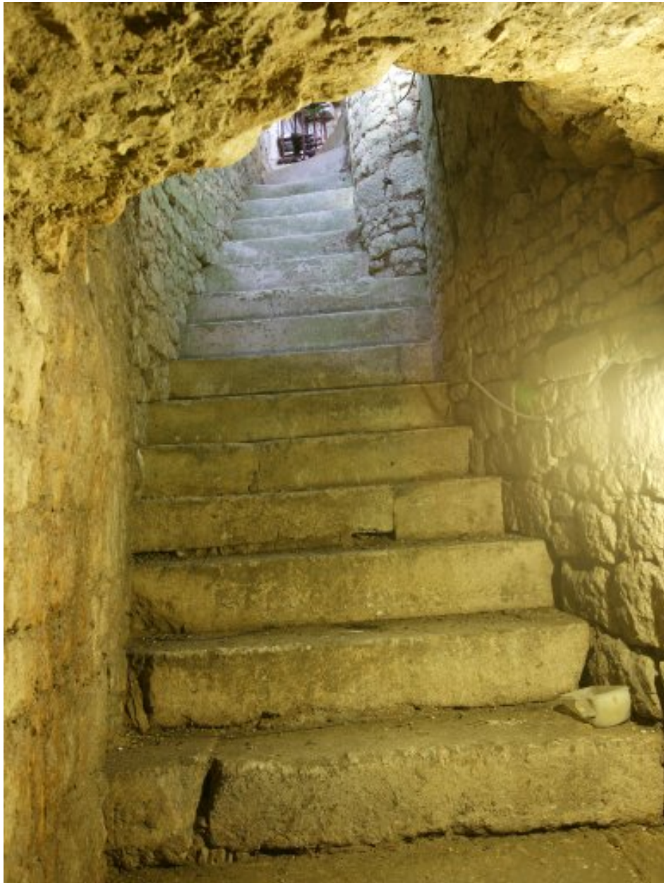
Escalier de descente au sous-sol : vue prise du bas.
