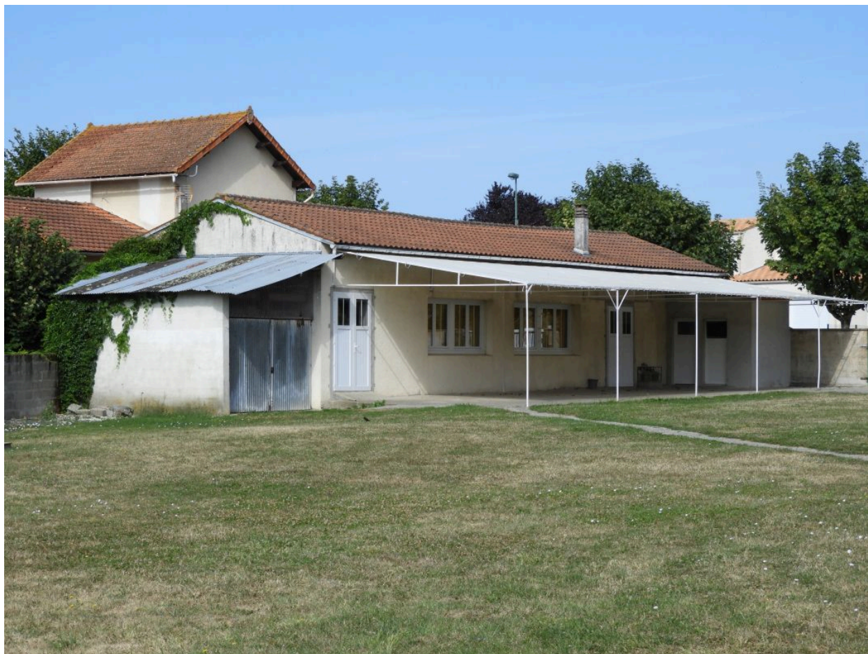
Le bâtiment de bureaux, devenu salle paroissiale, vu depuis l'est.
