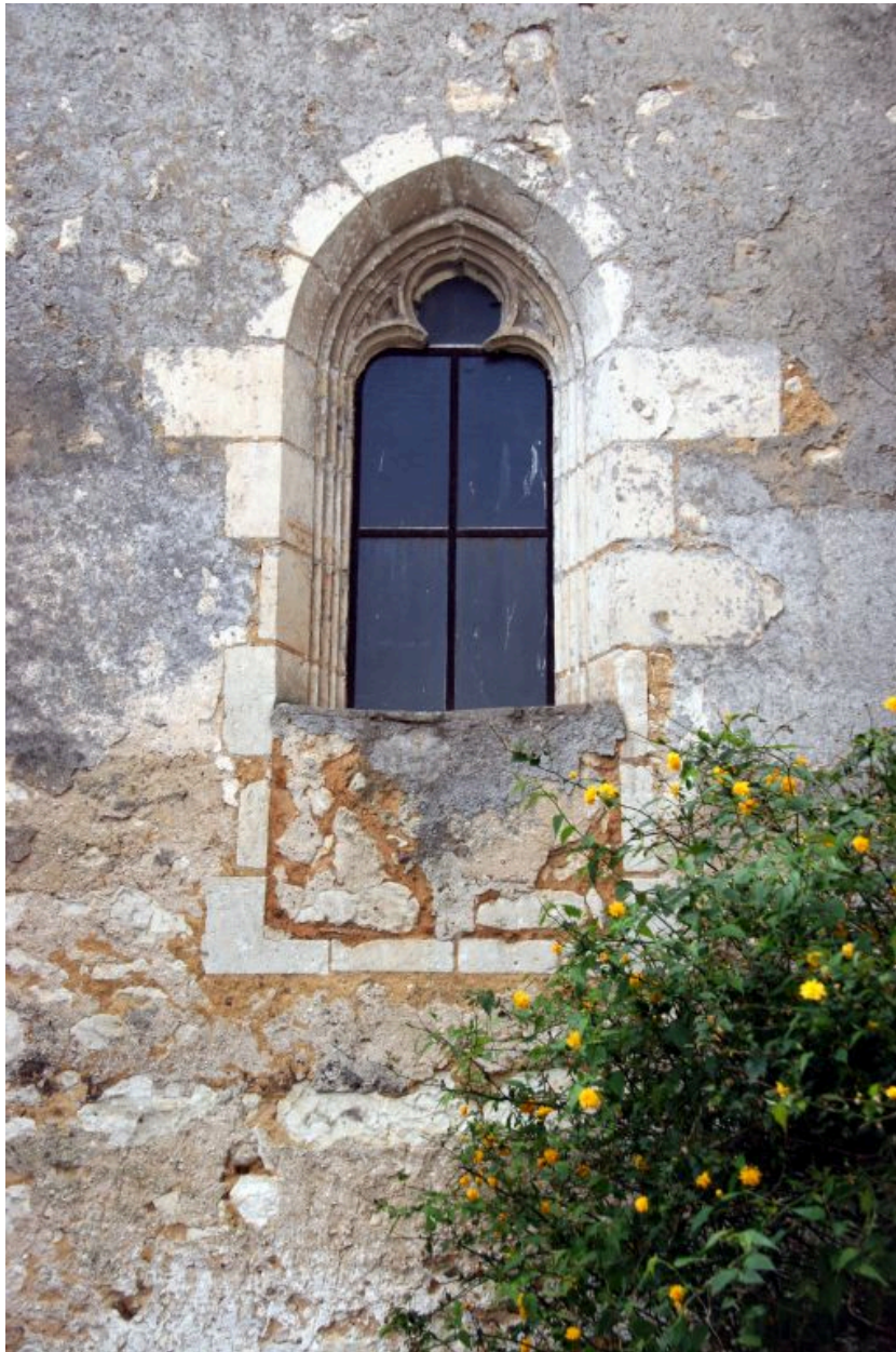
Mur nord de la nef, détail : baie.
