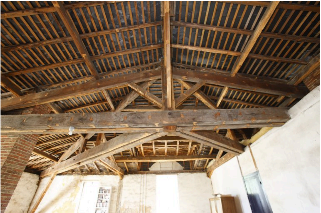
Vue de la charpente.
