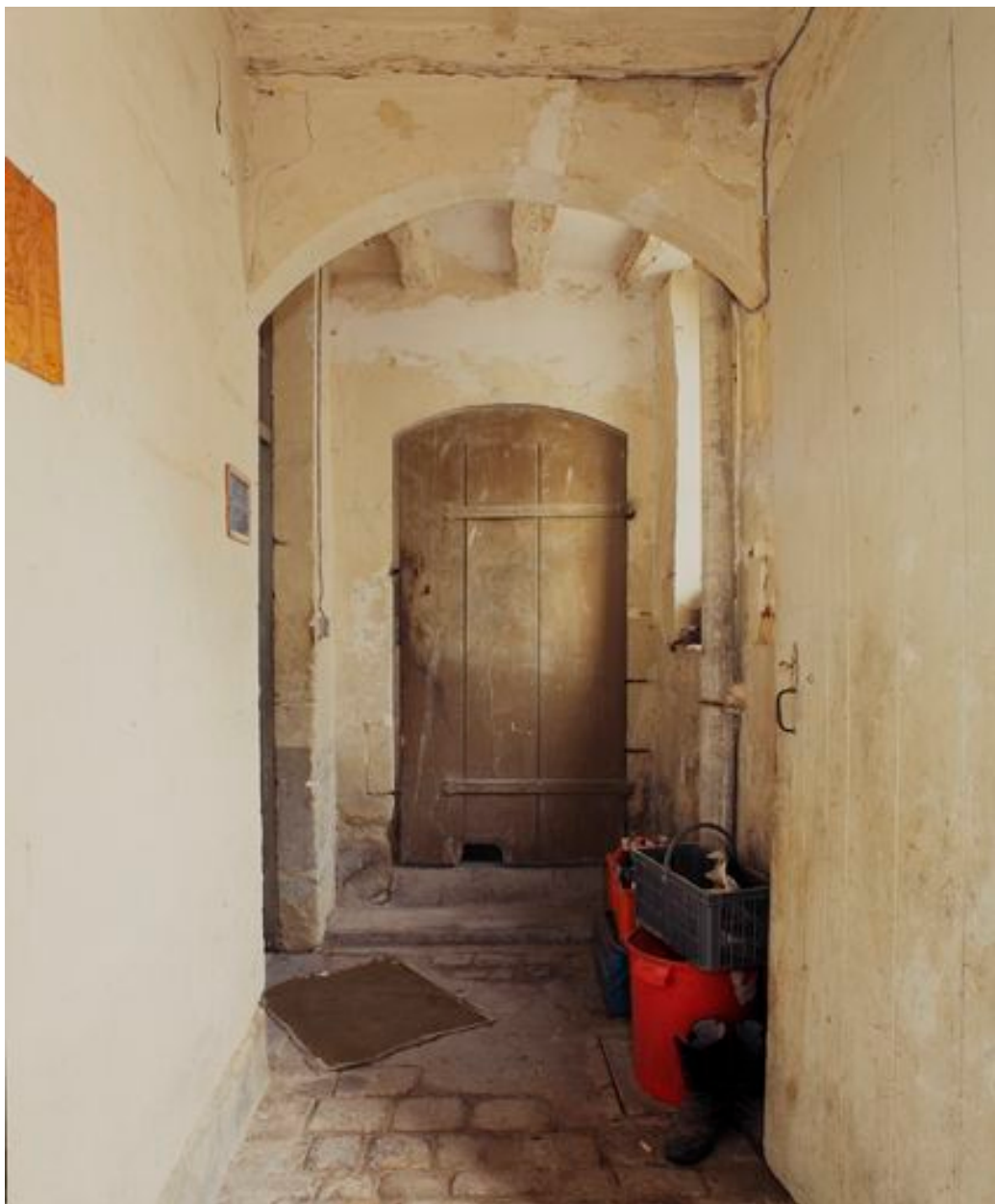
Logis (état 1996). Rez-de-chaussée, couloir est, avec porte d'accès à l'escalier.
