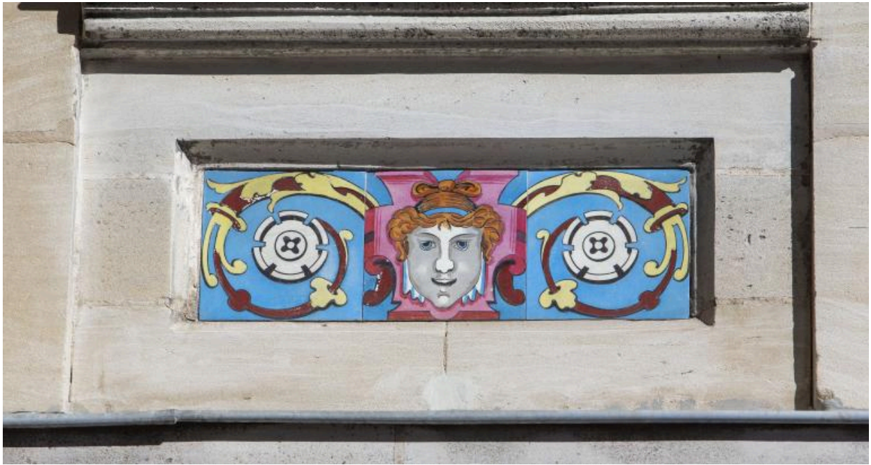
Détail des carreaux de céramique en façade.
