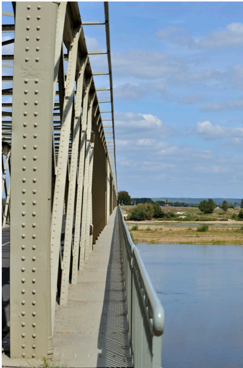
Voie piétonne, entre cage et garde-corps (est)
