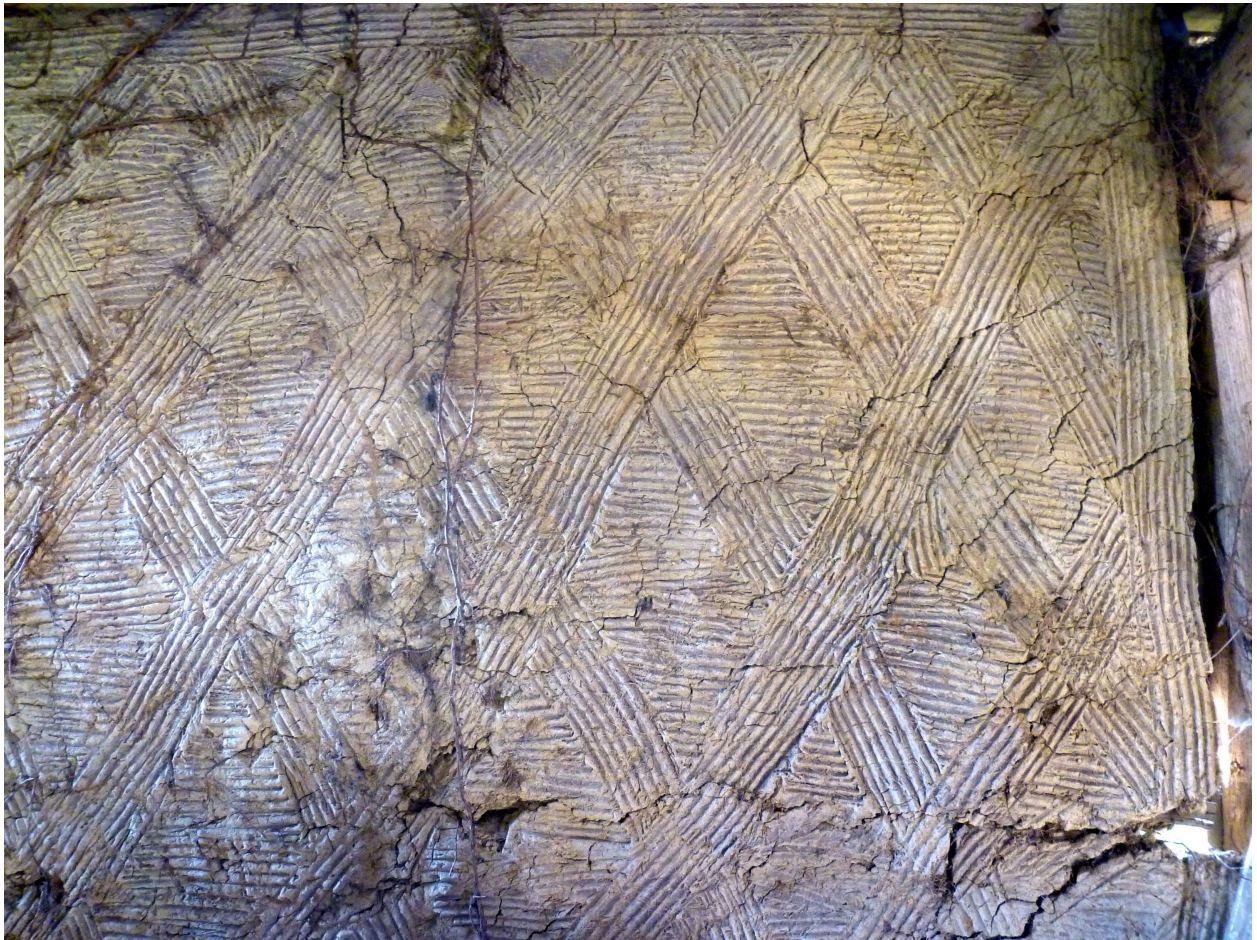
Détail du hourdis de torchis de la remiseau droit du logis 1.
