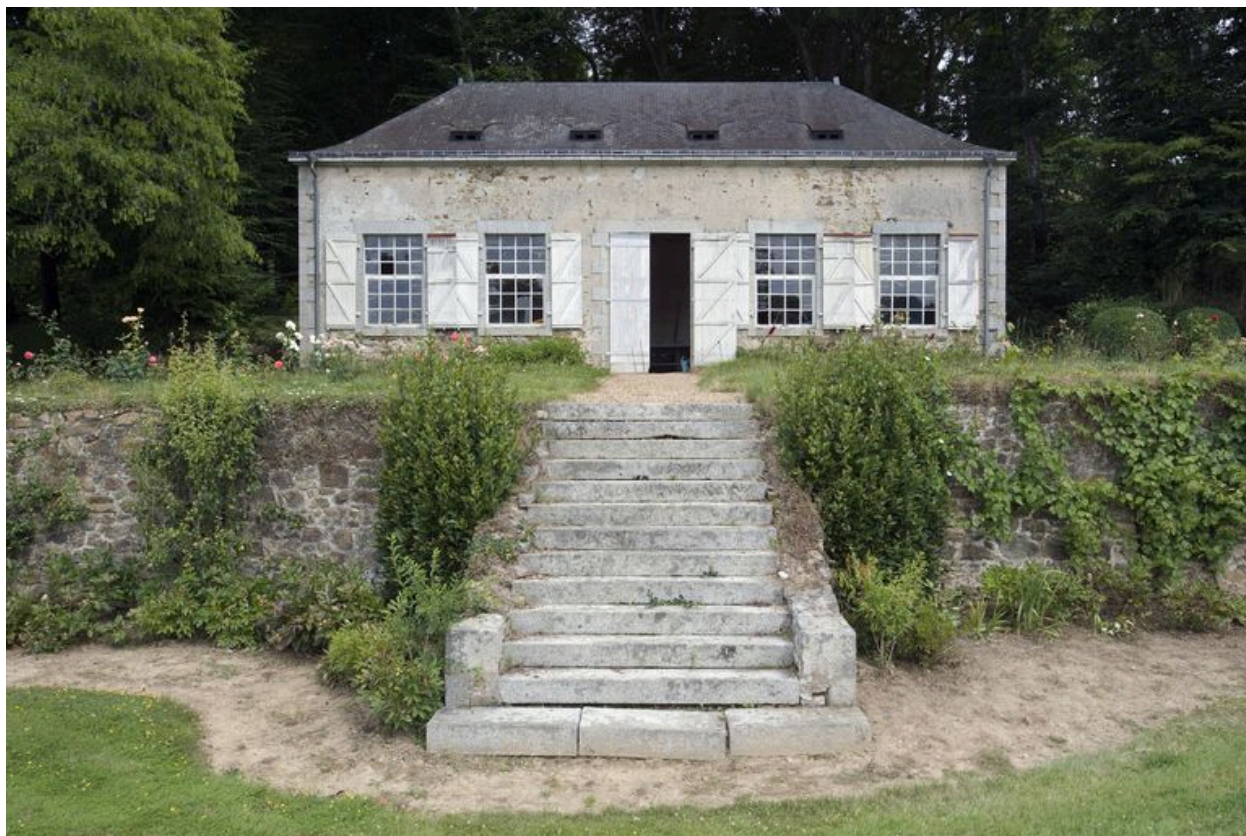
L'orangerie : vue d'ensemble depuis le sud.
