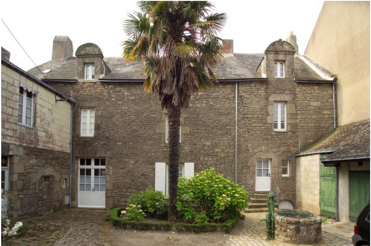
Vue de la façade nord donnant sur la rue de Bizienne.
