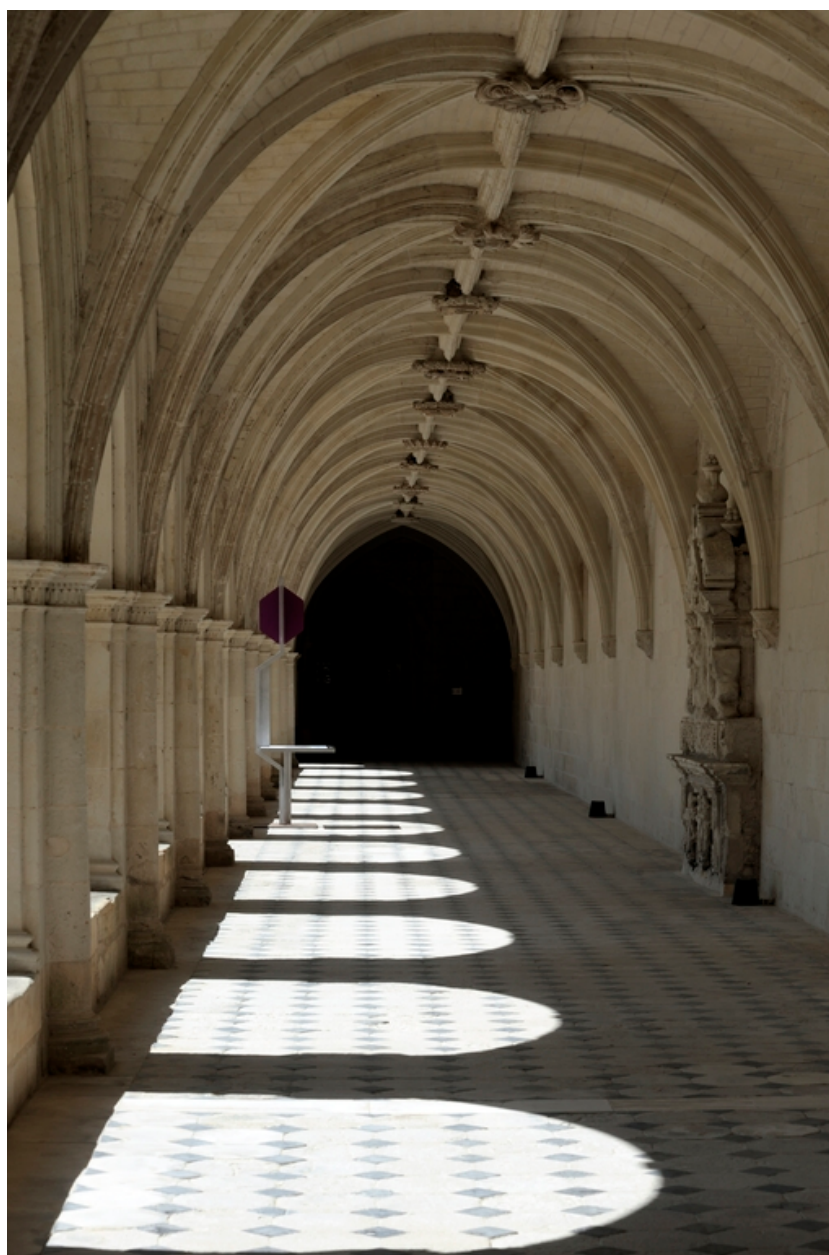
Cloître, galerie ouest (achevée vers 1550), couvrement.
