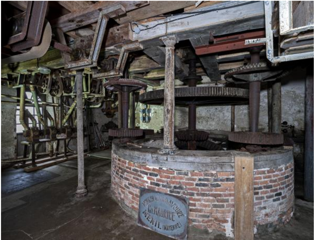
Rez-de-chaussée, partie nord-est vue depuis le sud-ouest : la poquerie contenant le système de transmission du moulin. Au fond, les conduites pneumatiques.
