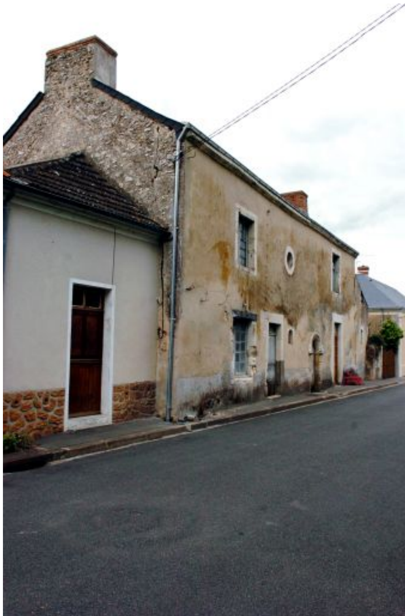
Façade antérieure sur rue.
