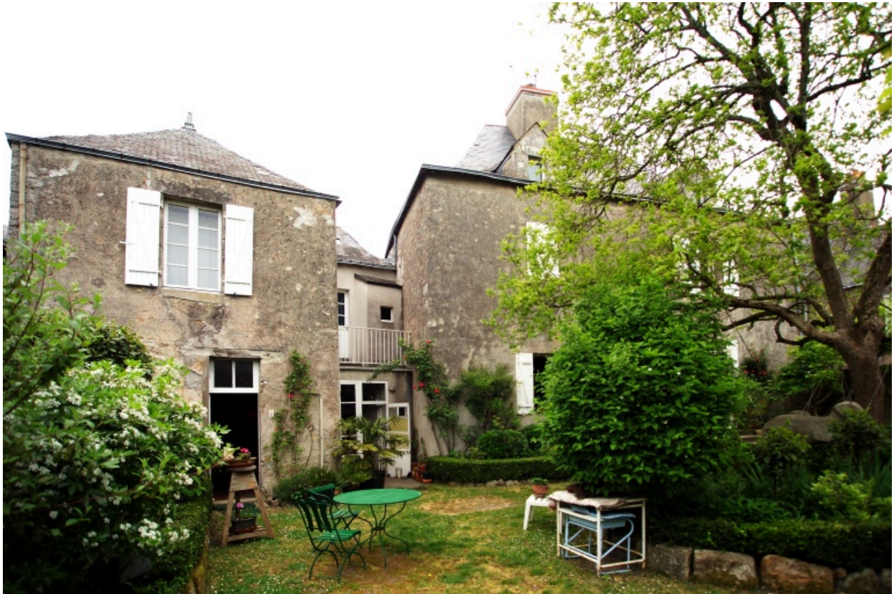
Vue d'ensemble vers le Nord.
