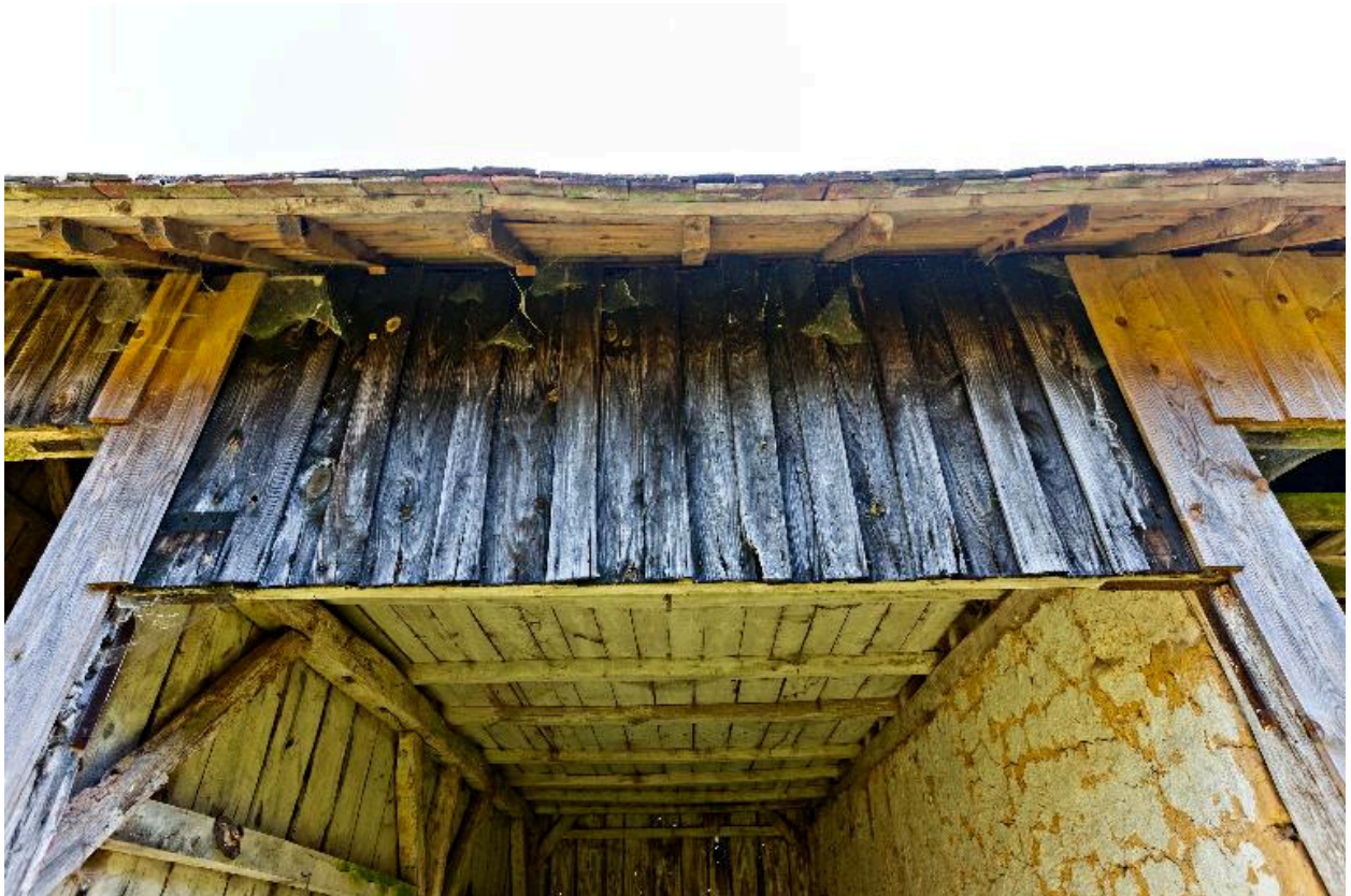
Détail de l'essentage de planche de l'élévation sur cour des communs.
