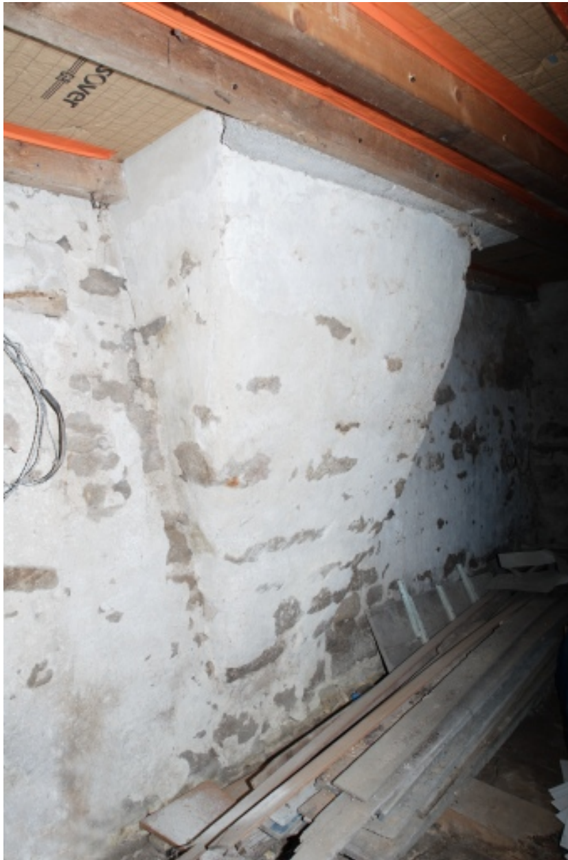
Détail de la souche de cheminée du cellier du logis nord.
