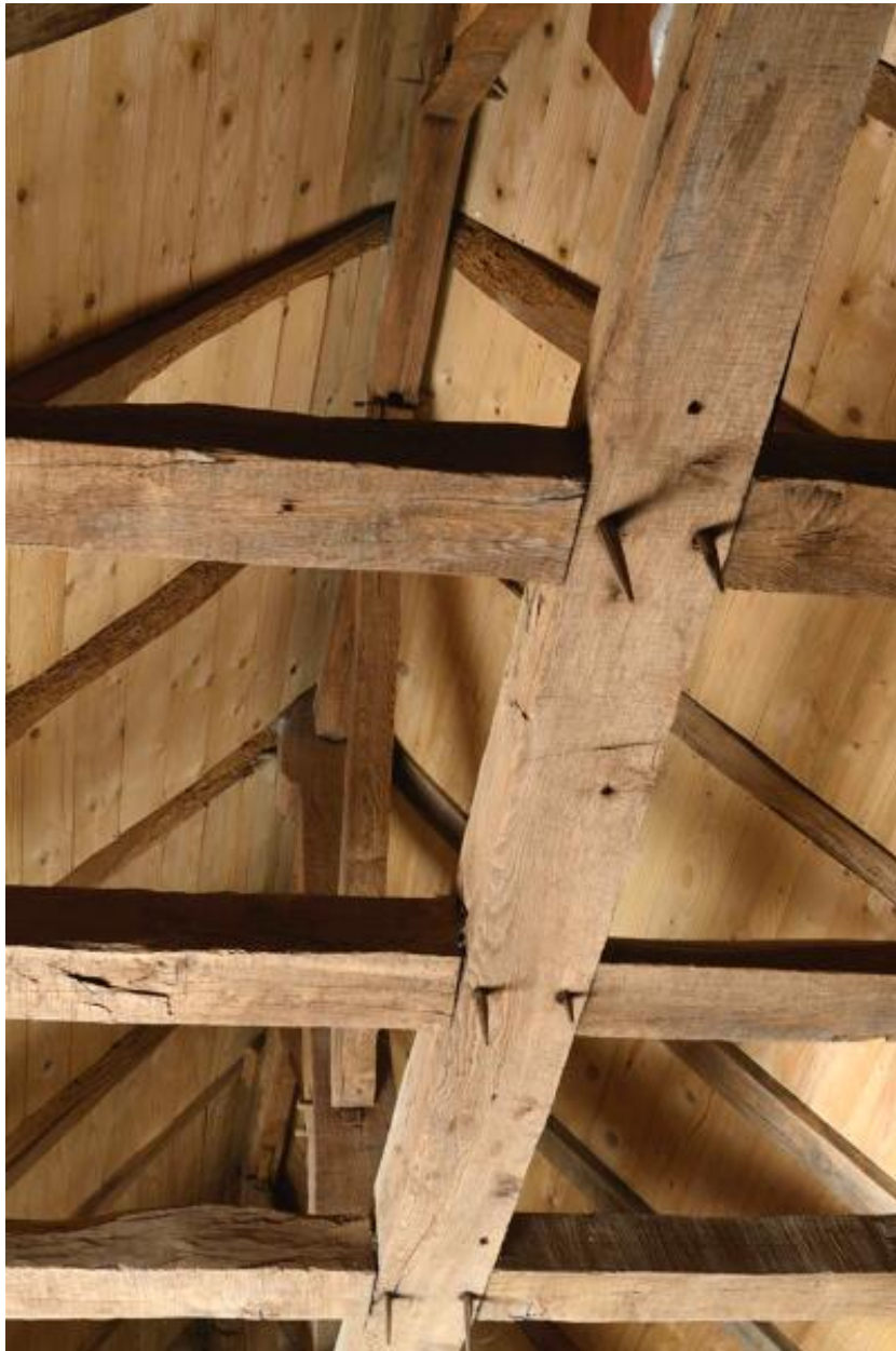
Détail de la charpente du logis.
