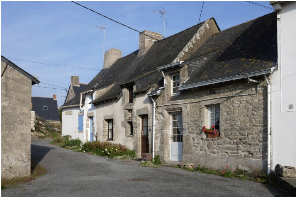
Vue depuis l'ouest de la partie nord de la rangée (2, 4, 6 rue de l'Aha).
