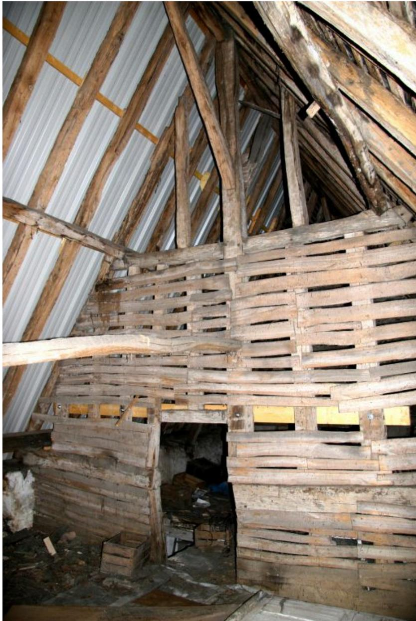
Comble : cloison en ais accrochée sur la ferme de la charpente.
