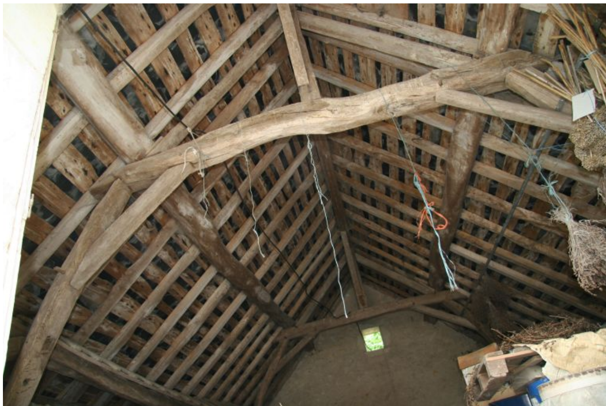
Écurie de l'autre côté du chemin : charpente (1897).
