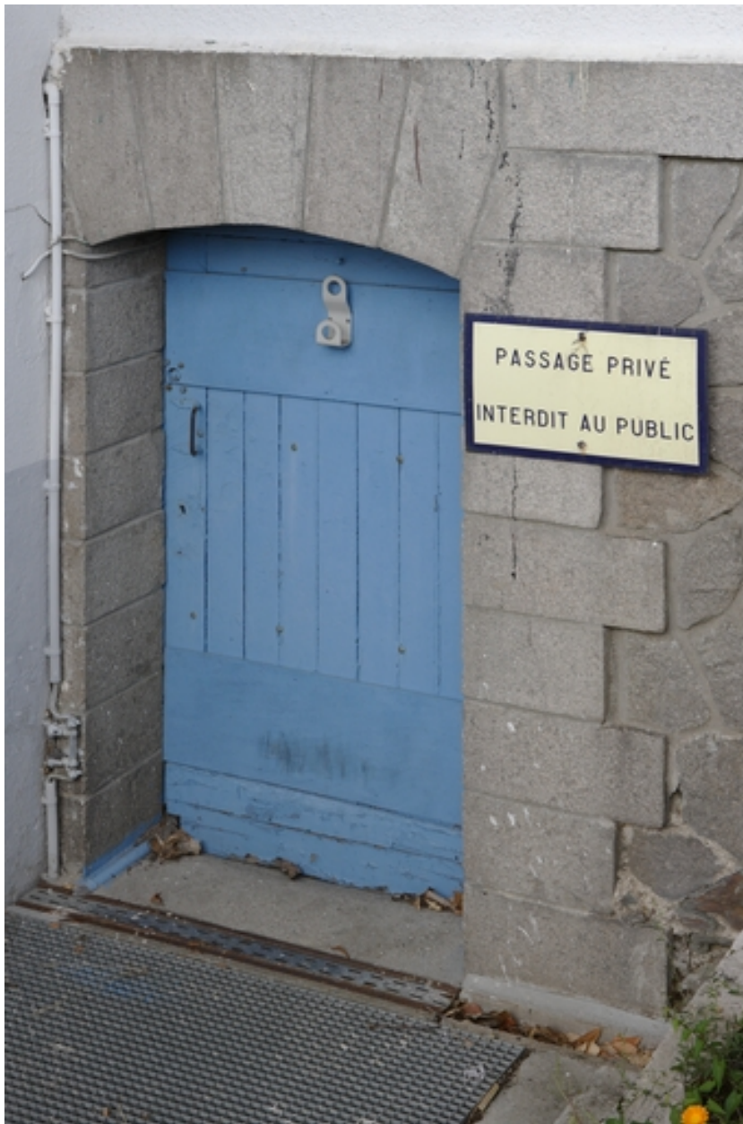
Porte d'accès au sous-sol.
