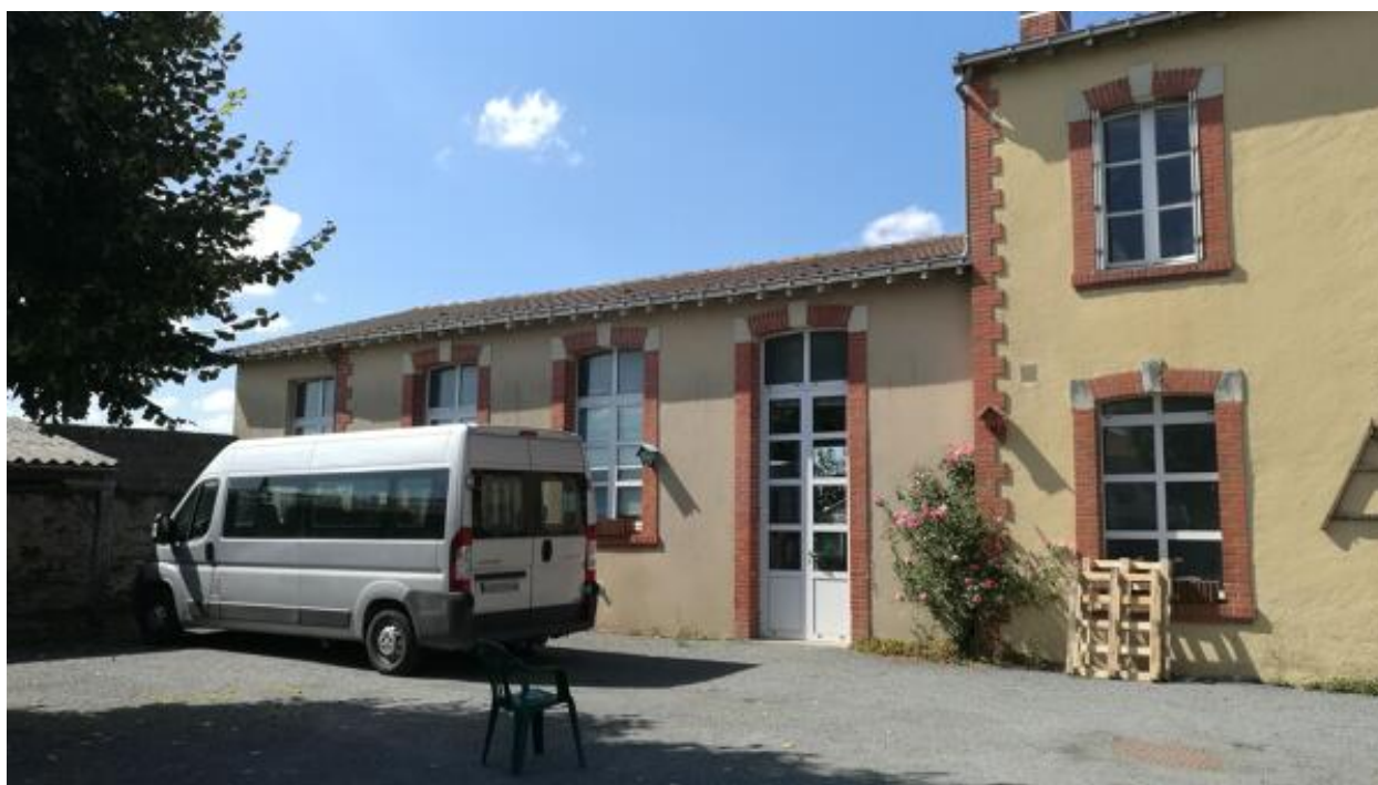
Vue de la salle de classe ouest.
