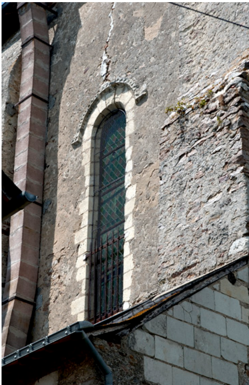
Détail du flanc sud : baie cintrée en tuffeau.
