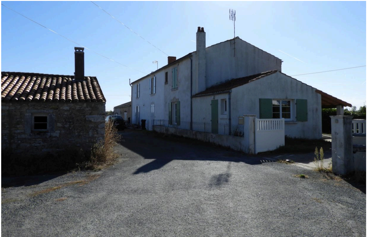
Le logis et, à gauche, la buanderie vus depuis le nord-ouest.
