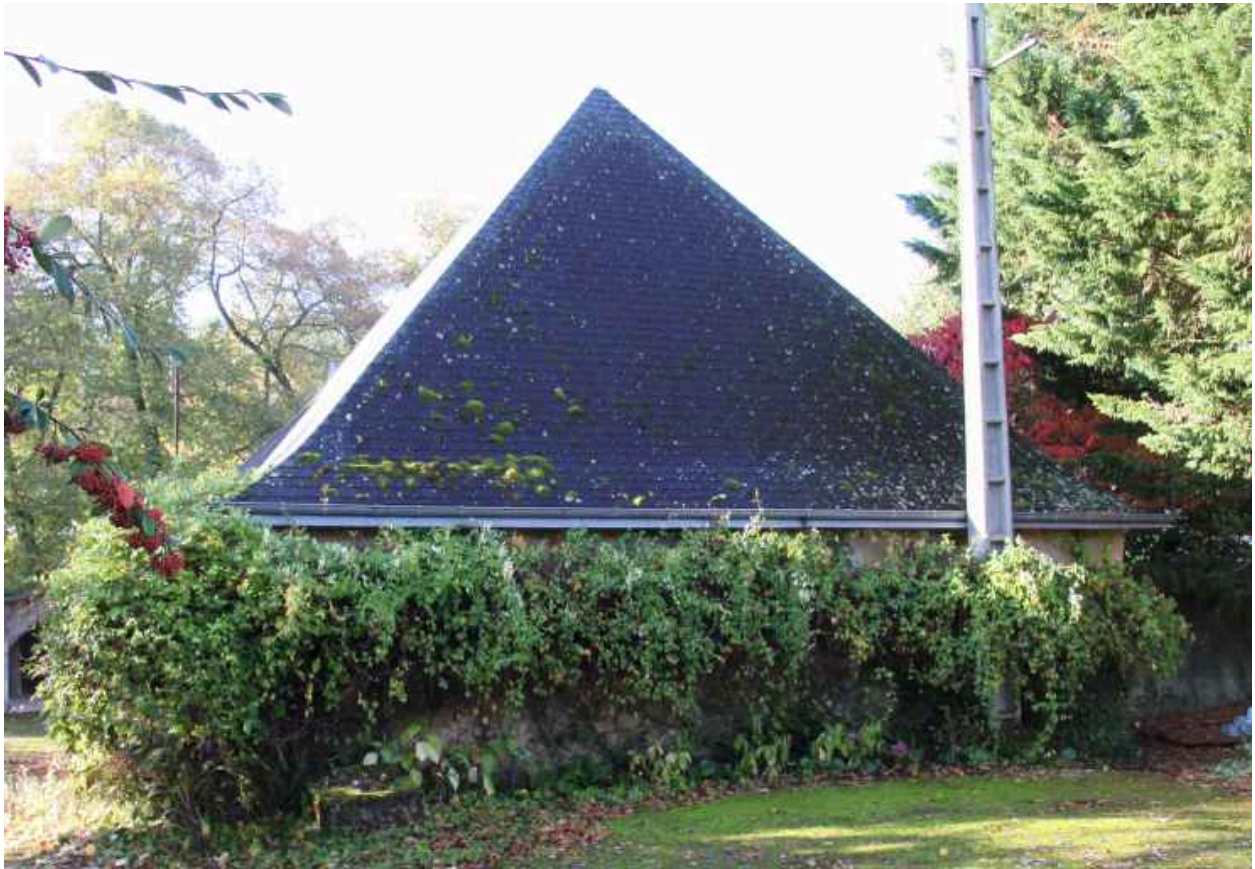
La ferme du château, la grange : croupe du pignon nord.
