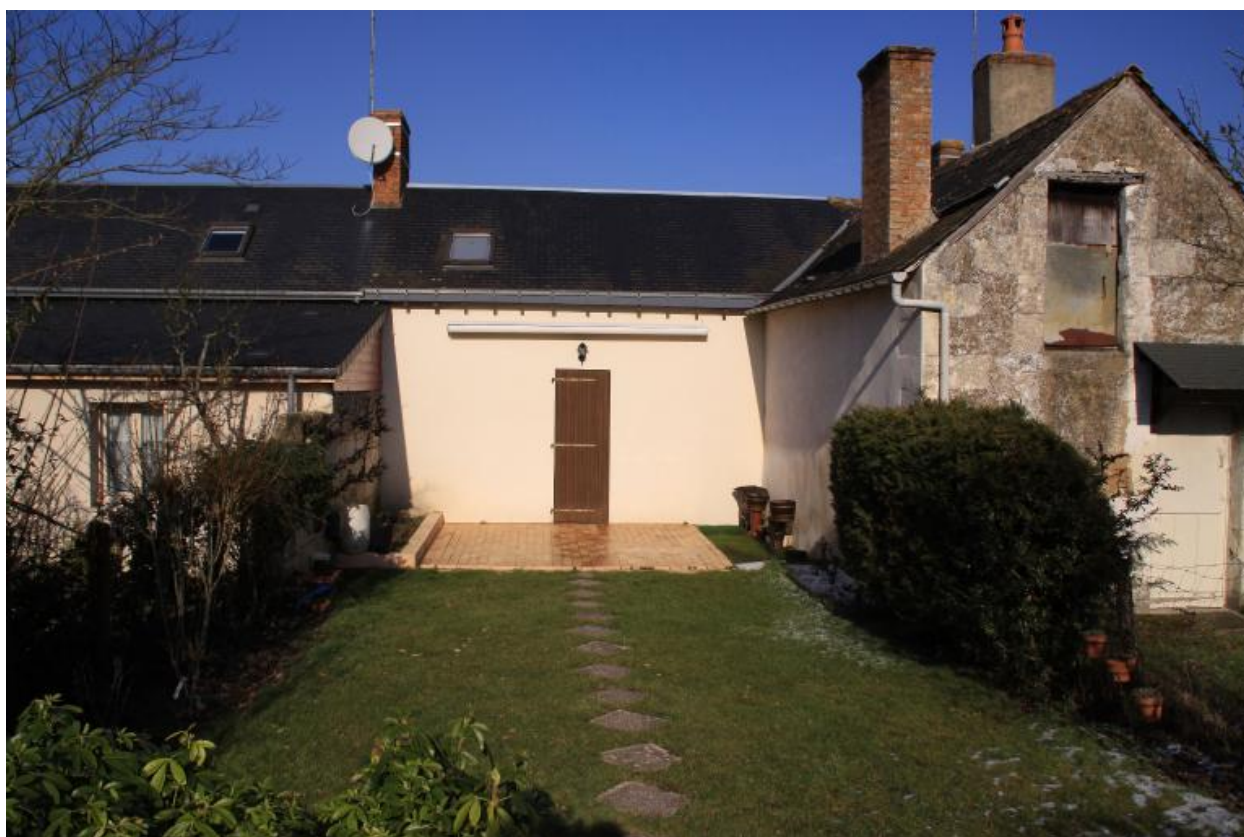
Façade sur jardin : logement.
