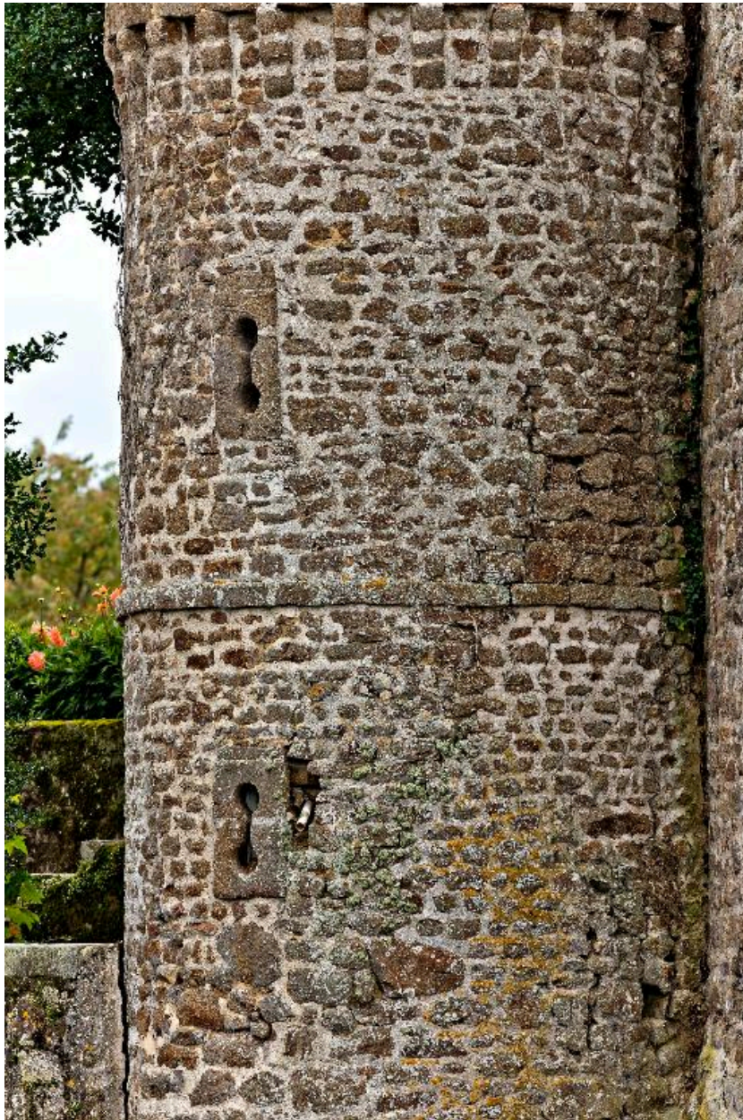
La tourelle et sa jonction avec la tour nord vues depuis le nord.
