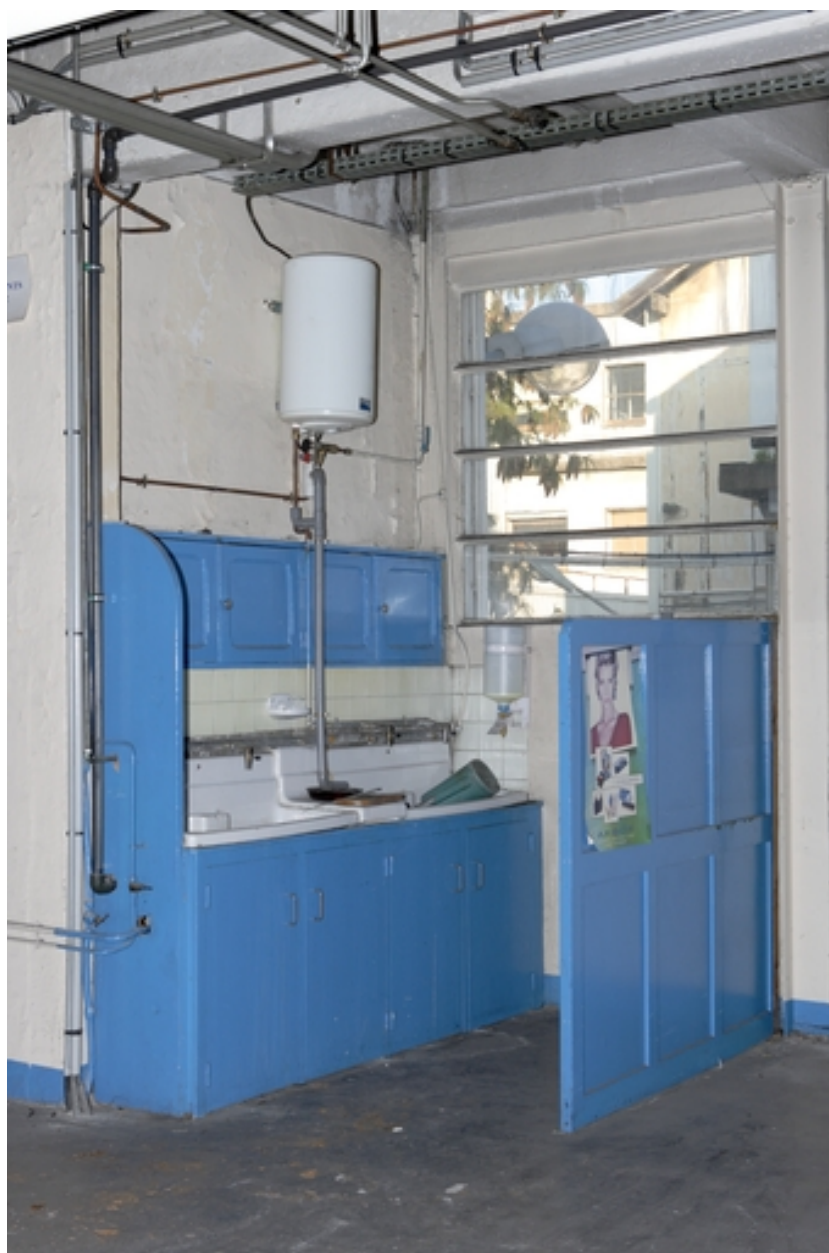
Atelier de fabrication 1, lave-mains.
